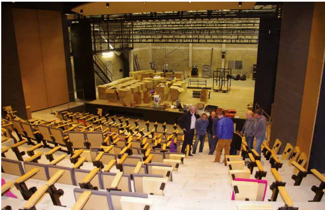
Réunion de chantier pour les travaux dans la salle
